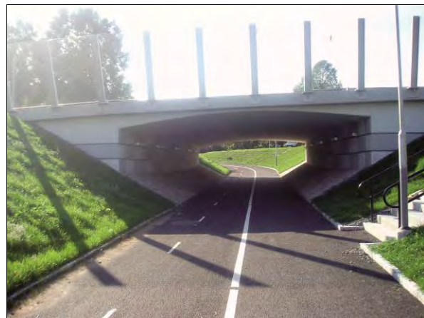
Bild 7. Exempel på gång- och cykeltunnel med goda siktförhållanden (Foto: GCM-handboken)
